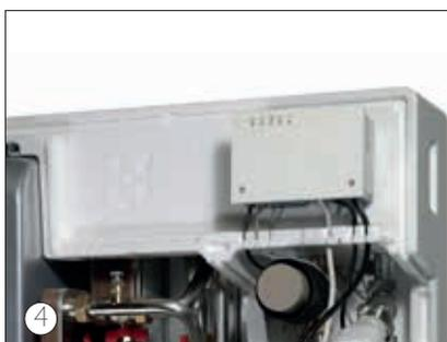
4. Måleren monteres i de markerede huller (se nedenfor) eller udenfor unittens top via hullerne i kabinettets top.
